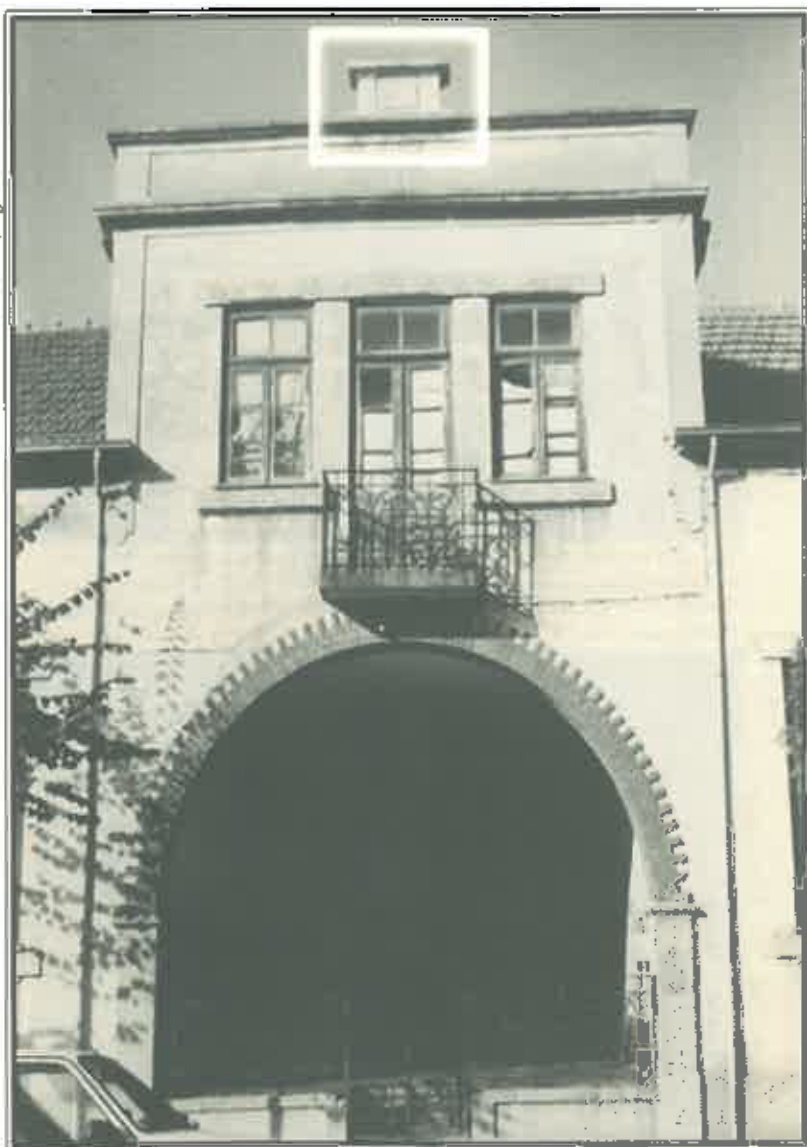
Fig. 14 - Escola Conde de Ferreira de Espinho, (Alçado voltado para a Rua 23) - Realce para a base do cimafrente que foi transportado da antiga fachada principal, e também para todo o corpo central, em especial, o vão que dá acesso ao interior do edifício.
