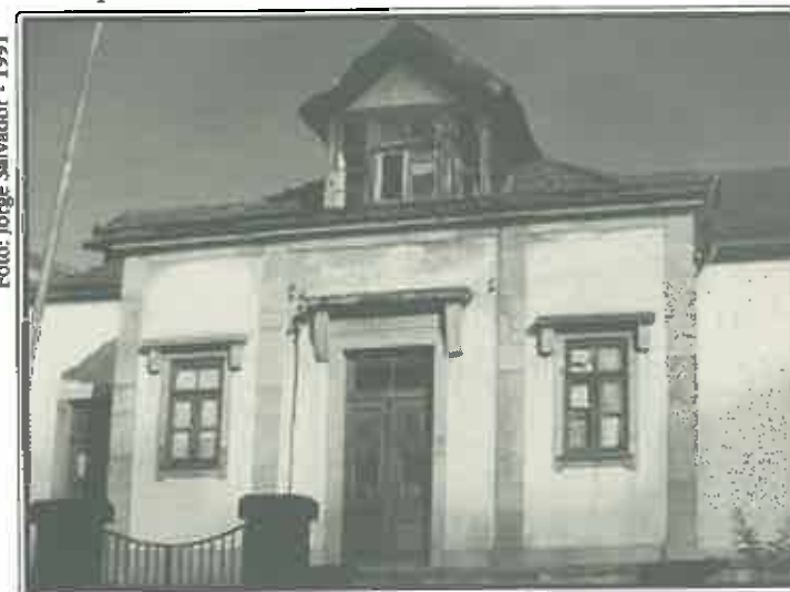
Fig. 13 - Escola Conde Ferreira de Espinho (Alçado voltado à Rua 12) - É evidente o traço do edifício original, e o corpo central acrescentado em 1912 que rasga os alçados laterais da primitiva construção. Realce também para as mansardas acrescentadas nesse projecto que substituem o cimafrente do edifício original cuja base foi transportada para a nova fachada.
