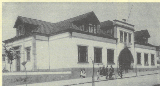
Com a reforma e ampliação do segundo edifício da "Escola Conde de Ferreira", a entrada principal ficou voltada para a Rua 23, enquanto que as entradas para a residência dos professores, ficou com serventia pelas alas nascente e poente.
