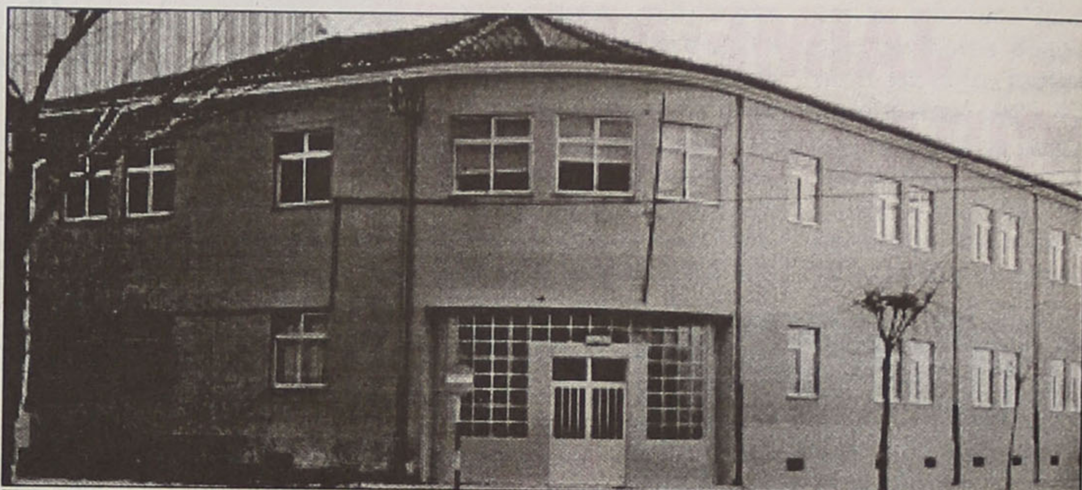
Edifício onde em tempos funcionou o famoso colégio
