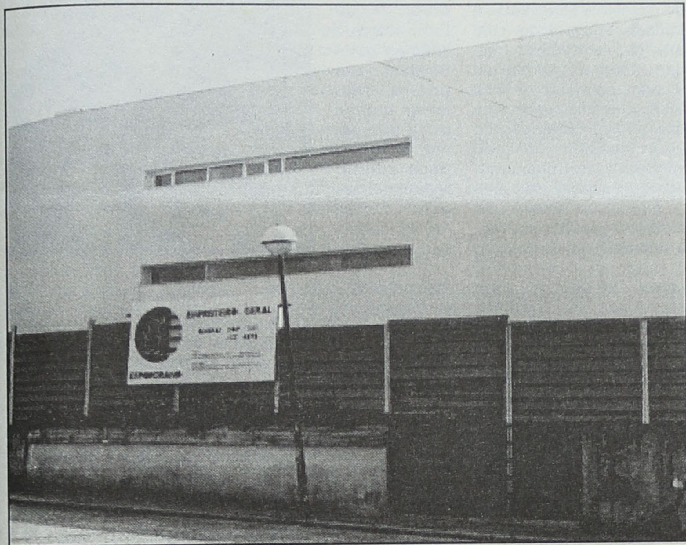
O novo edifício da Santa Casa da Misericórdia deverá estar concluído antes do Verão
