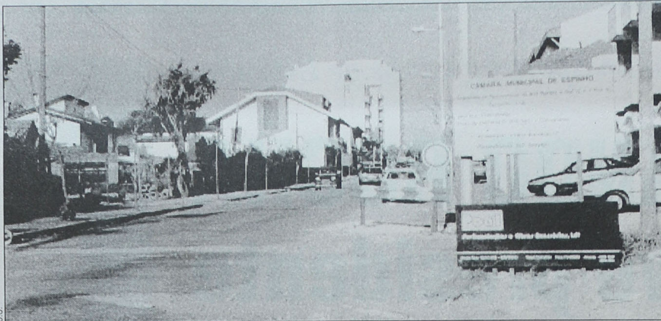
As obras da Rua 19 provocam várias certezas e algumas dúvidas à bancada do PSD
