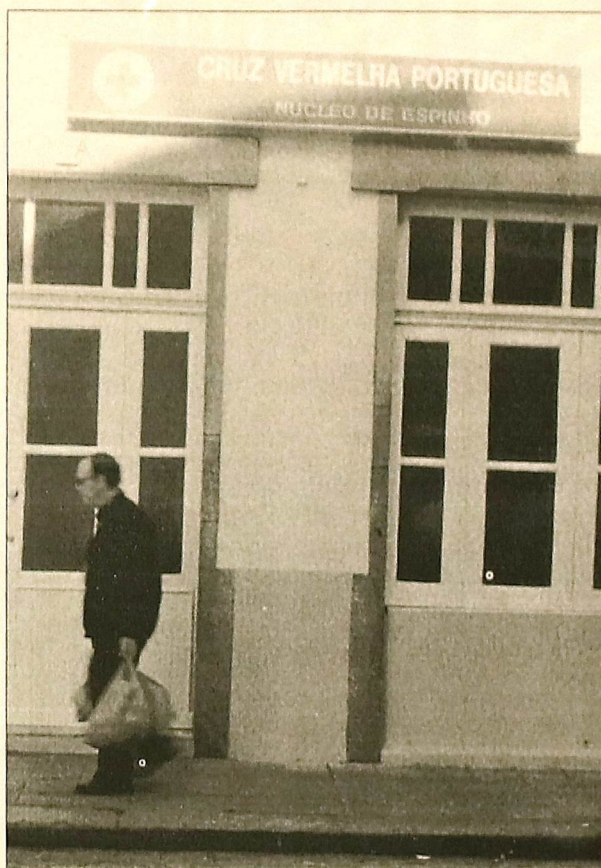
A sede do Núcleo, no edifício do Mercado Municipal
