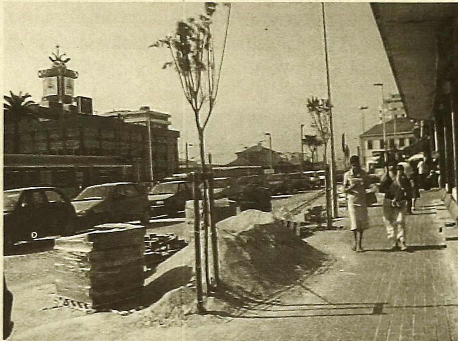
Depois da requalificação urbana, comerciantes desesperam com enterramento da linha
