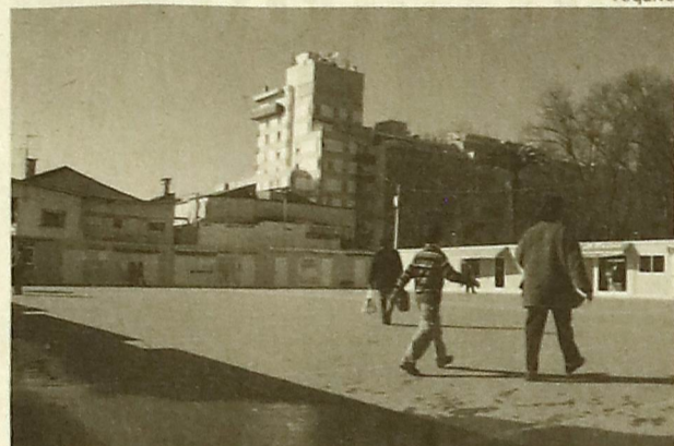
Subsolo do mercado recebe parque de estacionamento
