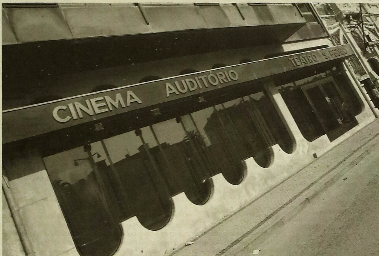
A degradação é o novo ocupante do Cine Teatro
