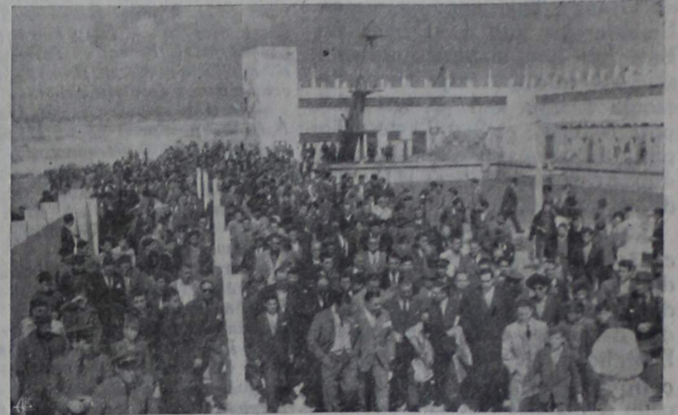
O Sr. Engenheiro Arantes e Oliveira, Ministro das Obras Públicas, acompanhado dos elementos oficiais e dos jornalistas, depois de observar os estragos ao Norte da Praia, atravessa o interior da Piscina, iniciando a marcha em direcção ao extremo Sul da Praia a fim de visitar o «Bairro Flexa».
