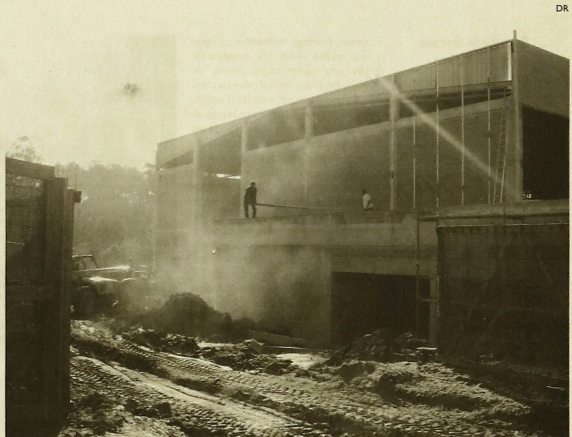
O novo pavilhão municipal sediado em Anta começa a ter a estrutura erguida
