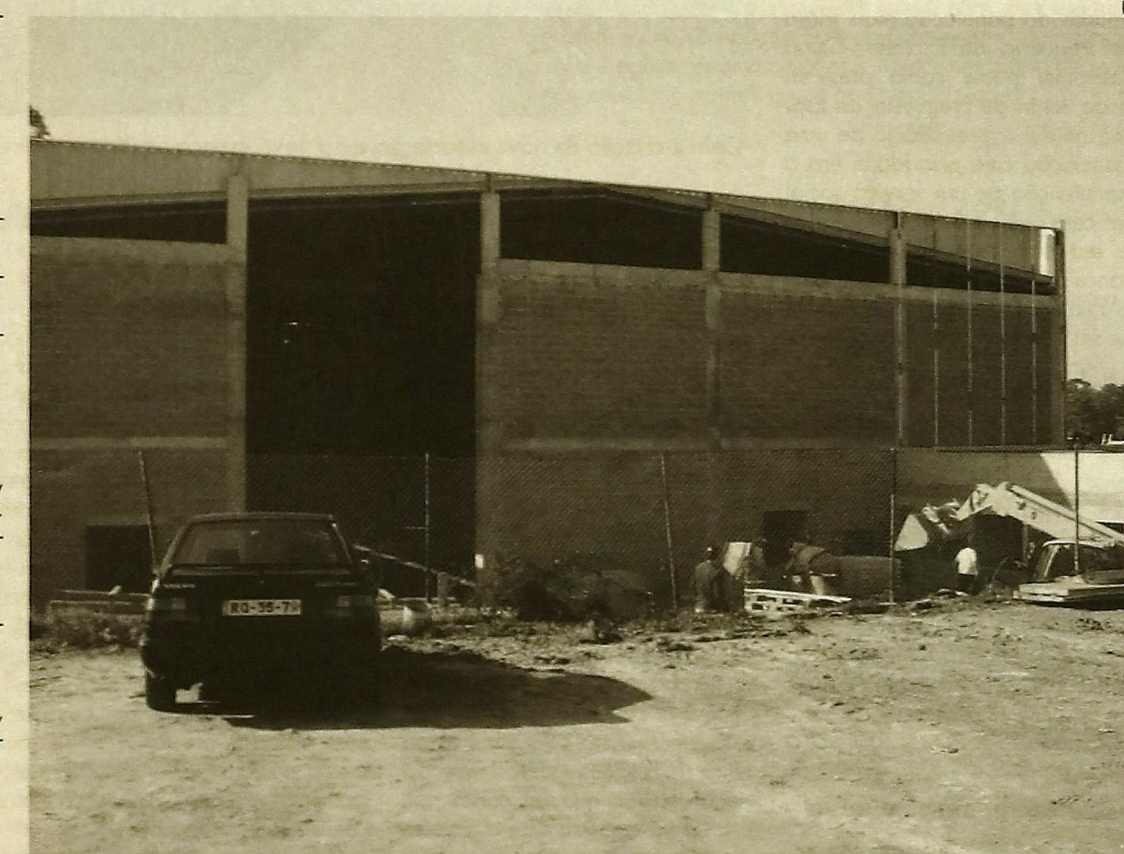
Concluída a edificação do pavilhão seguir-se-á a obra dos arranjos exteriores
