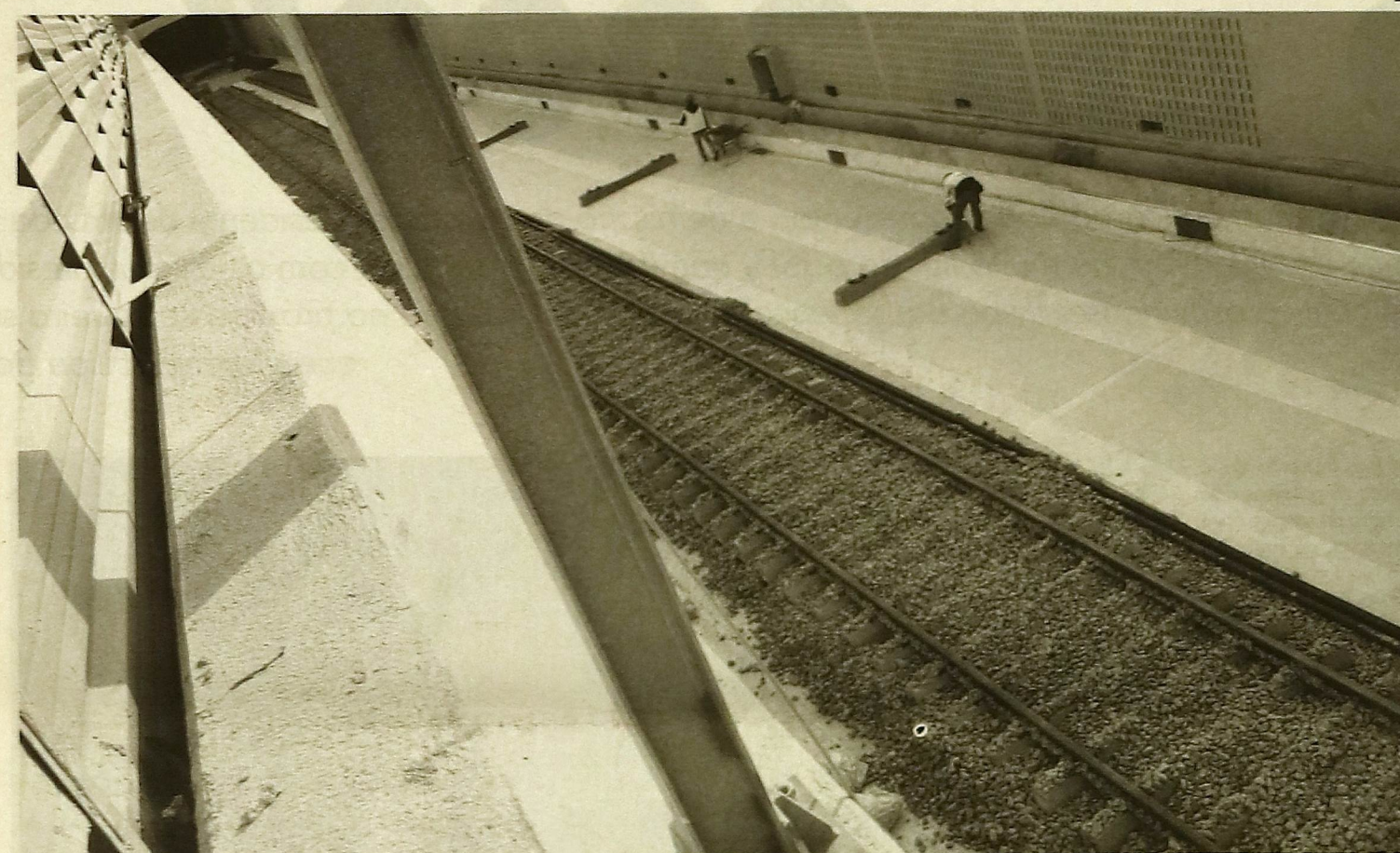
Apesar dos muitos benefícios que vai trazer a obra, o enterramento da linha-férrea trouxe, naturalmente, muitos inconvenientes
