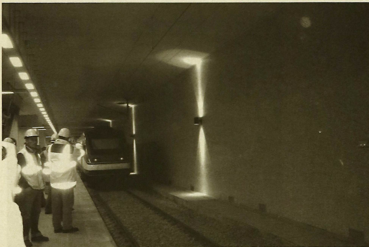
A passagem do Alfa Pendular no novo túnel ferroviário colocou um ponto final no comboio à superfície em Espinho
