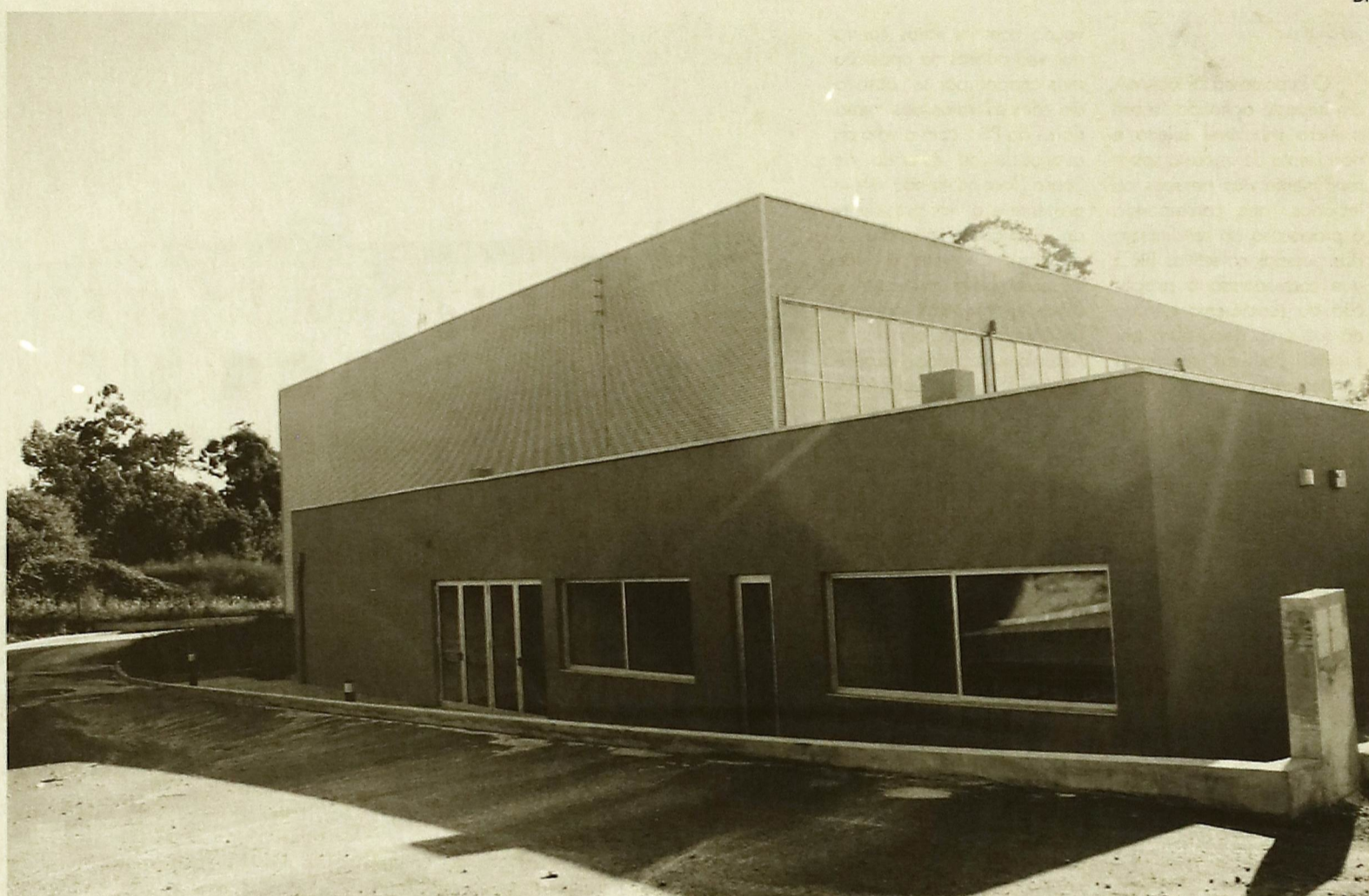
Faltam ainda os arranjos exteriores, no entanto, o Pavilhão de Anta já ganhou forma e dentro em breve será inaugurado
