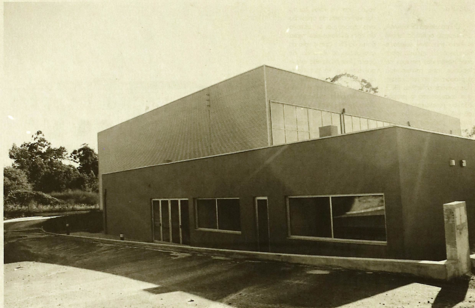
Faltam ainda os arranjos exteriores, no entanto, o Pavilhão de Anta já ganhou forma e dentro em breve será inaugurado
