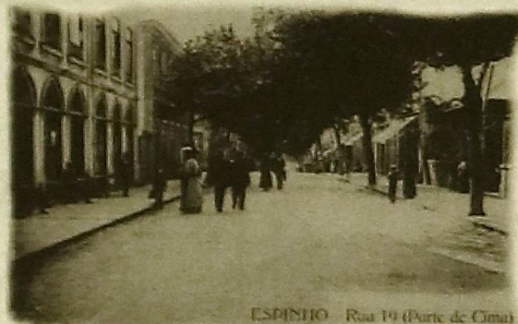
ESPINHO - Rua 19 (Parte de Cima)
