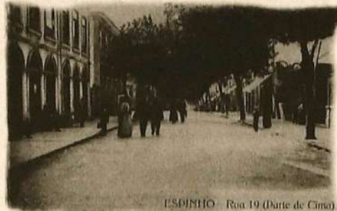
ESPINHO - Rua 19 (Parte de Cima)
