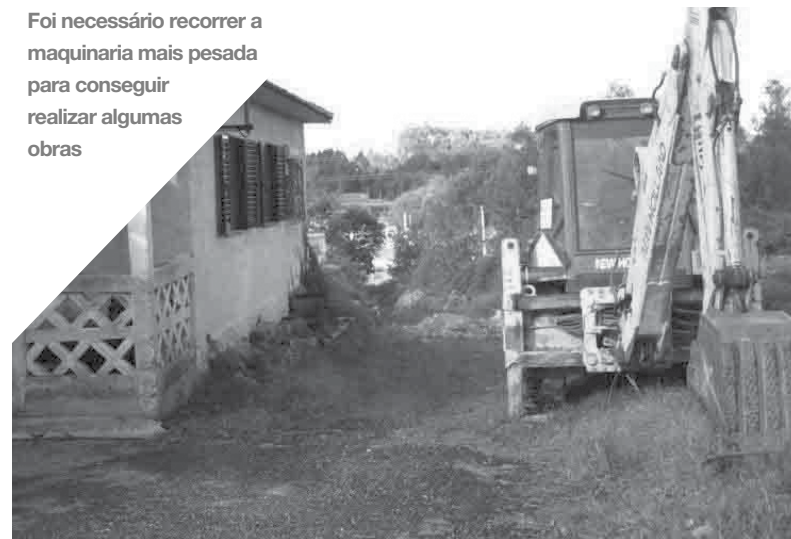
Terrenos precisaram de ser limpos antes de começarem as obras
