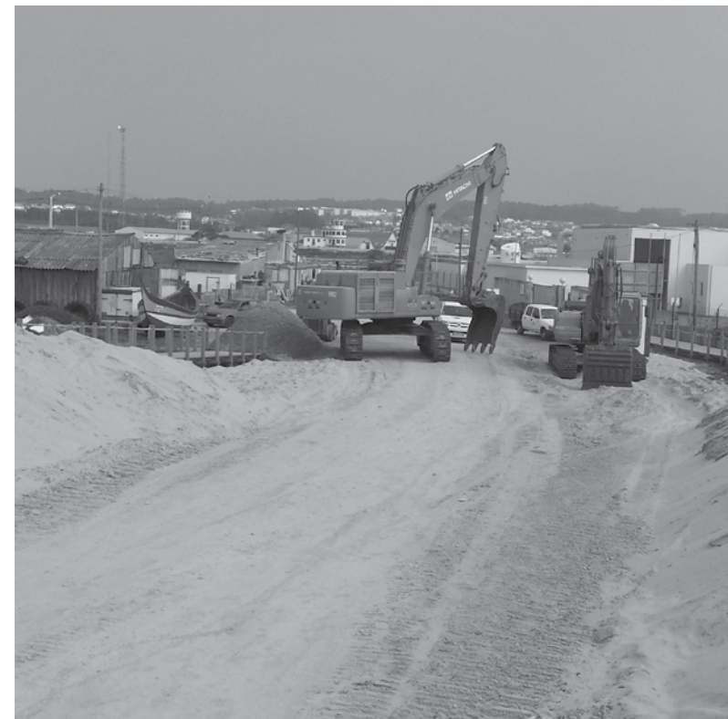
Máquinas em Paramos já efetuaram a primeira fase das obras na praia
