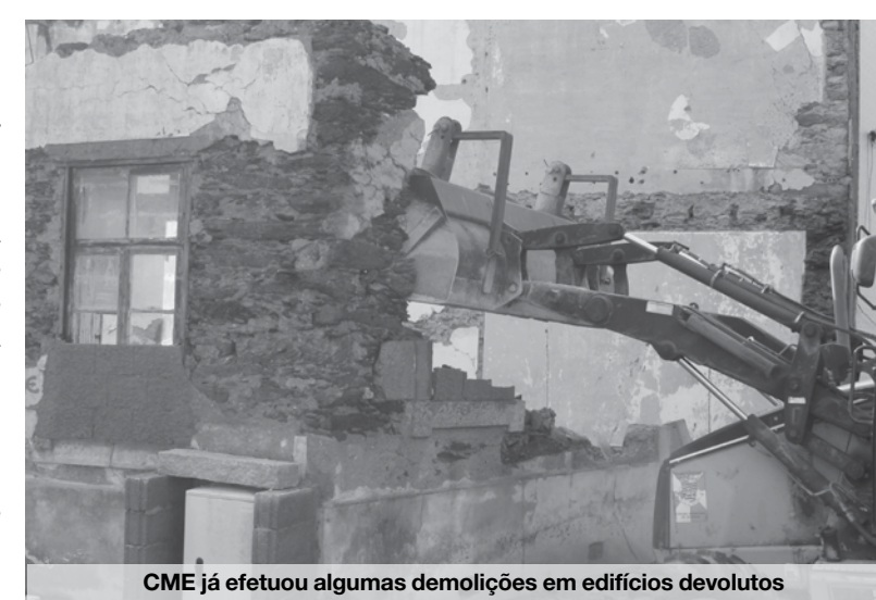
CME já efetuou algumas demolições em edifícios devolutos
