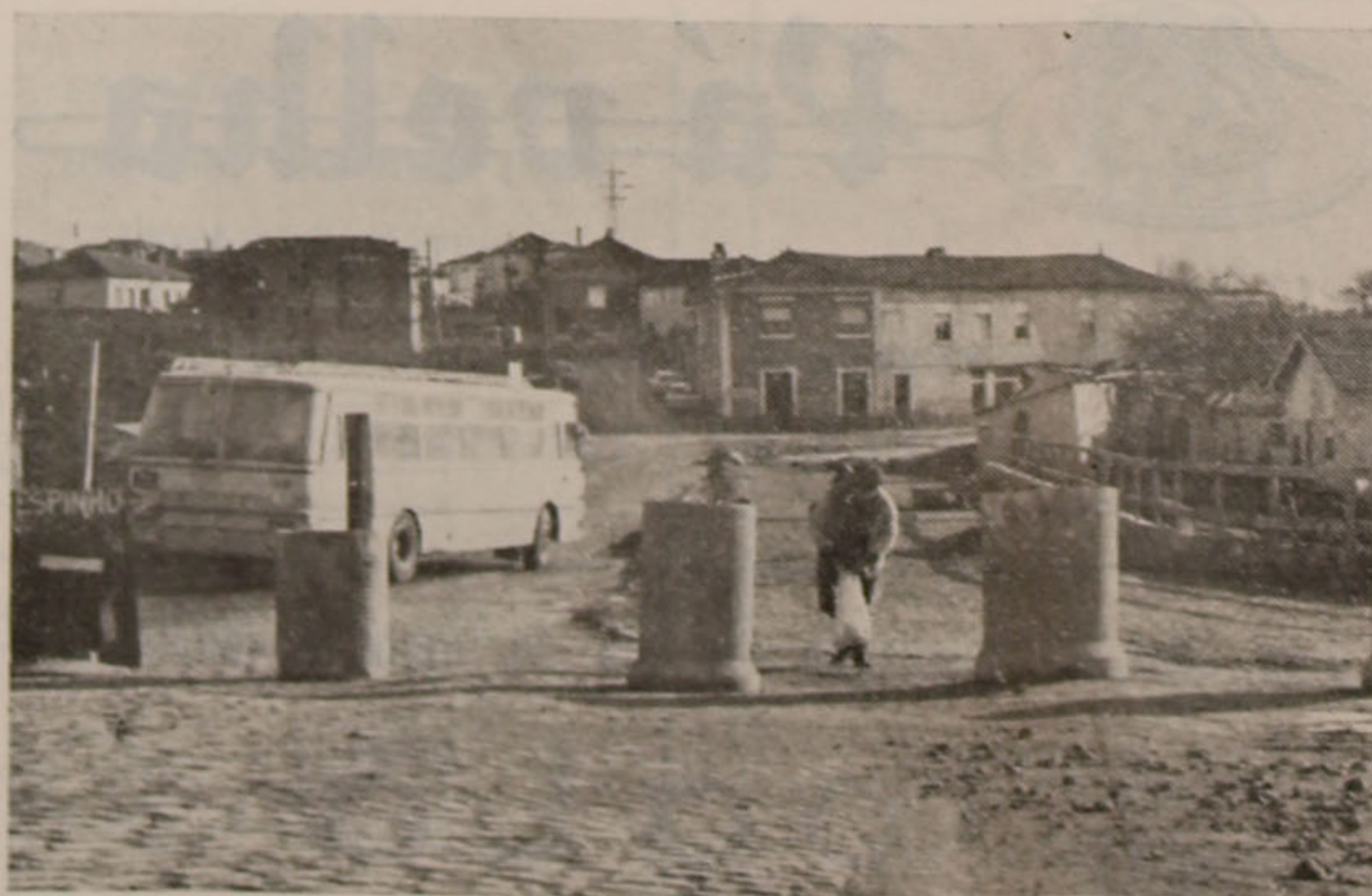
Com esta obra, o acesso norte da cidade vai melhorar sensivelmente, sendo a faixa de rodagem alargada para mais de 12 metros.
