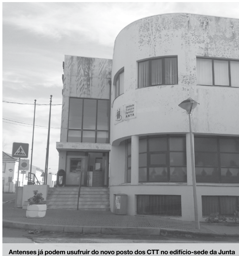
Antenses já podem usufruir do novo posto dos CTT no edifício-sede da Junta
