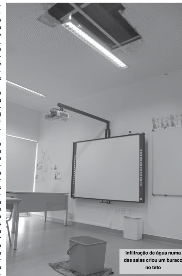
Infiltração de água numa das salas criou um buraco no teto
