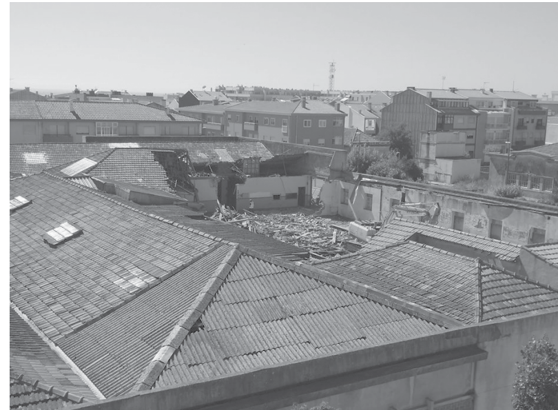
Obras na Fosforeira serão divididas em duas fases
