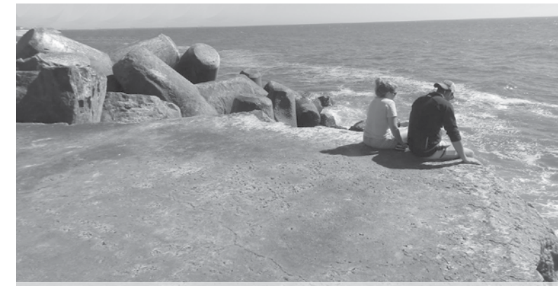
Esporões em Espinho há muito que precisam de obras de manutenção
