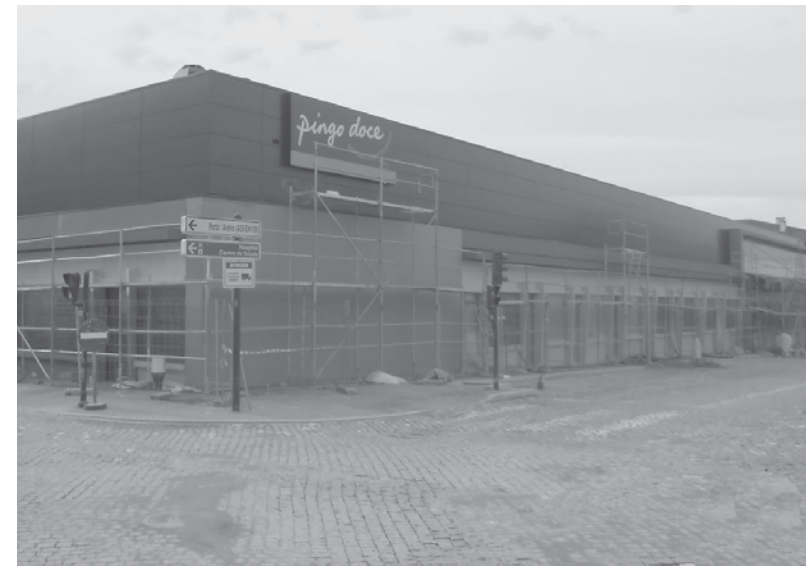
Primeira fase da construção na antiga Fosforeira já se encontra terminada
