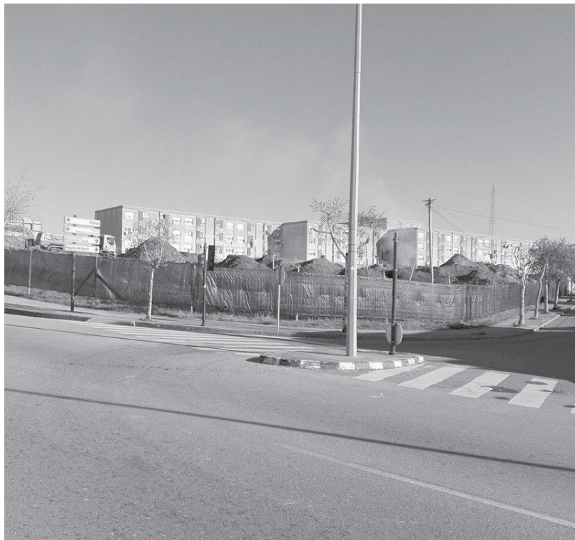
O terreno para a construção do posto de combustível já está vedado. Na intersecção deste cruzamento será construída uma rotunda.
