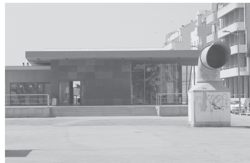
Obras no troço ferroviário entre Espinho e Ovar só devem acontecer em 2020
