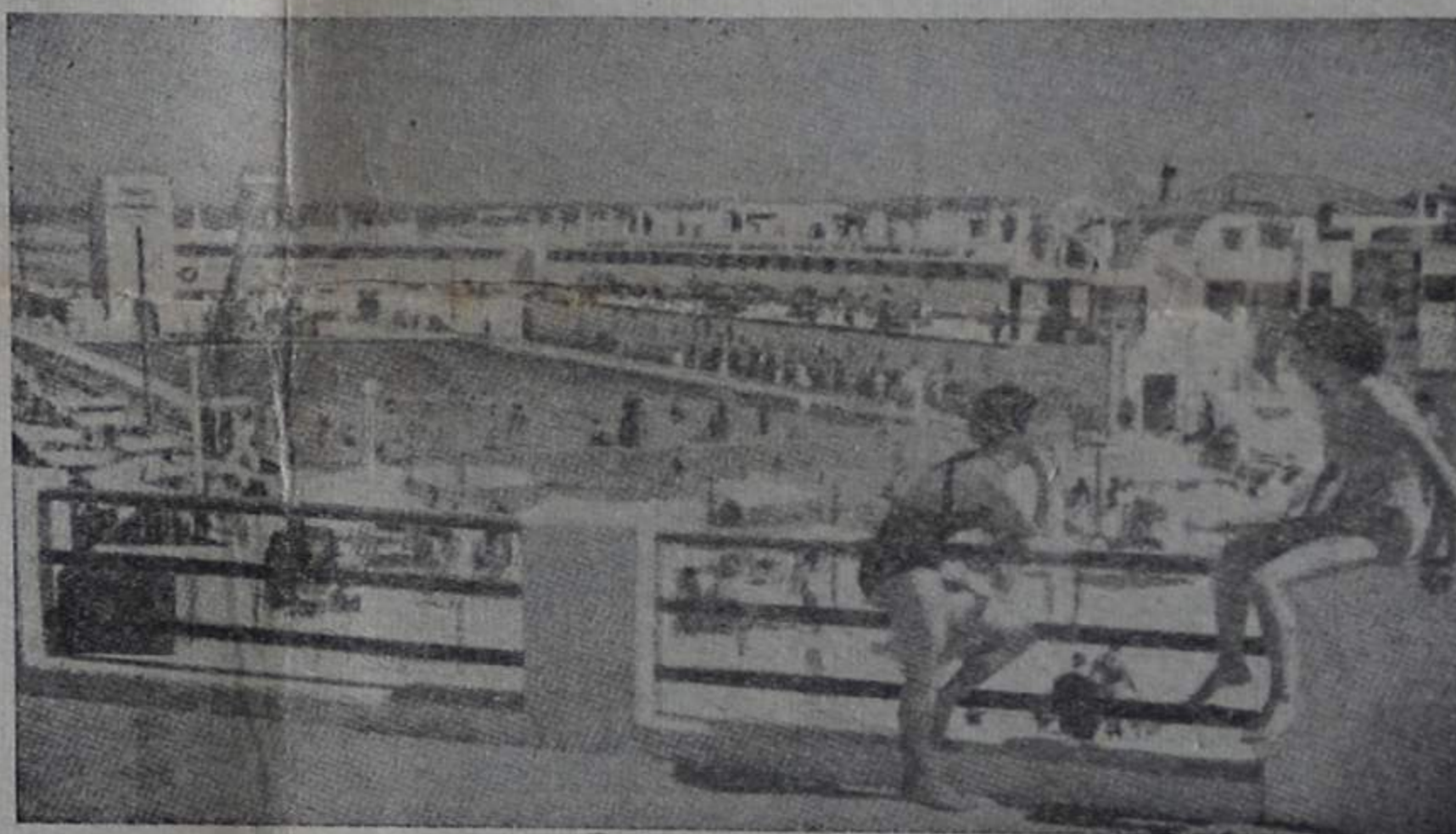
Vista parcial da Piscina Solário Atlântico
