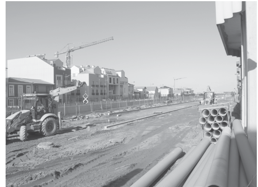
Primeira fase das obras arrancou na Rua 8
