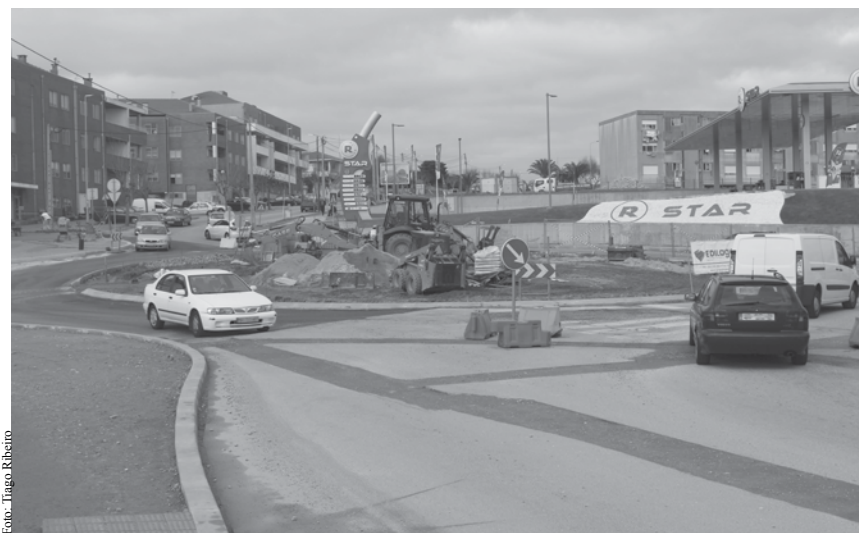
Obras na rotunda da Ponte de Anta já avançaram significativamente
