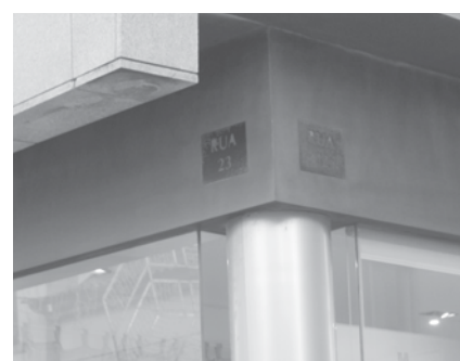
Gaveto Rua 23 e 12. Placas não são visíveis.
