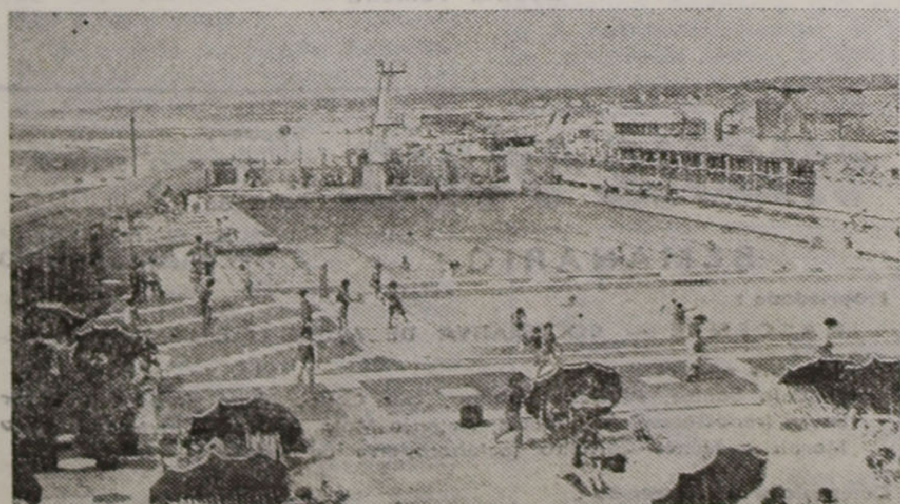
Reabriu já a Piscina, enquanto continuam as obras dos banhos quentes.
