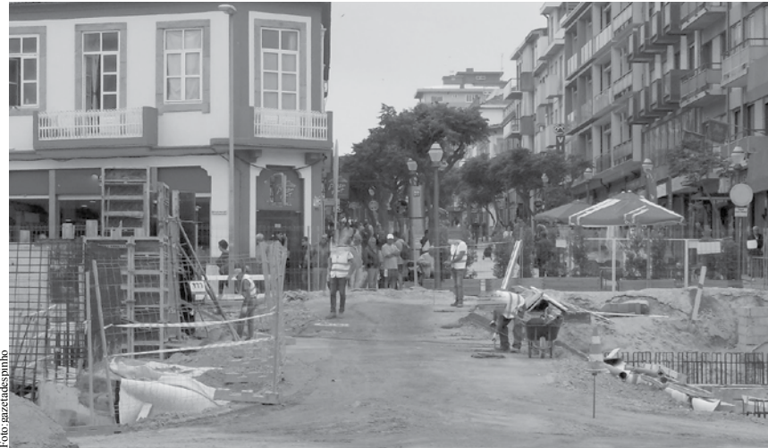
Acesso temporário está praticamente terminado.
