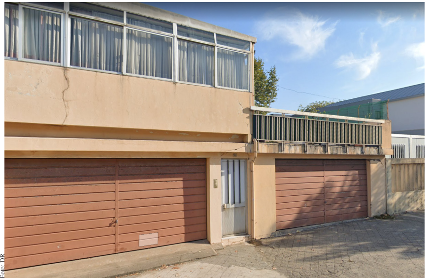
Homem ficou retido numa varanda do primeiro andar da residência.
