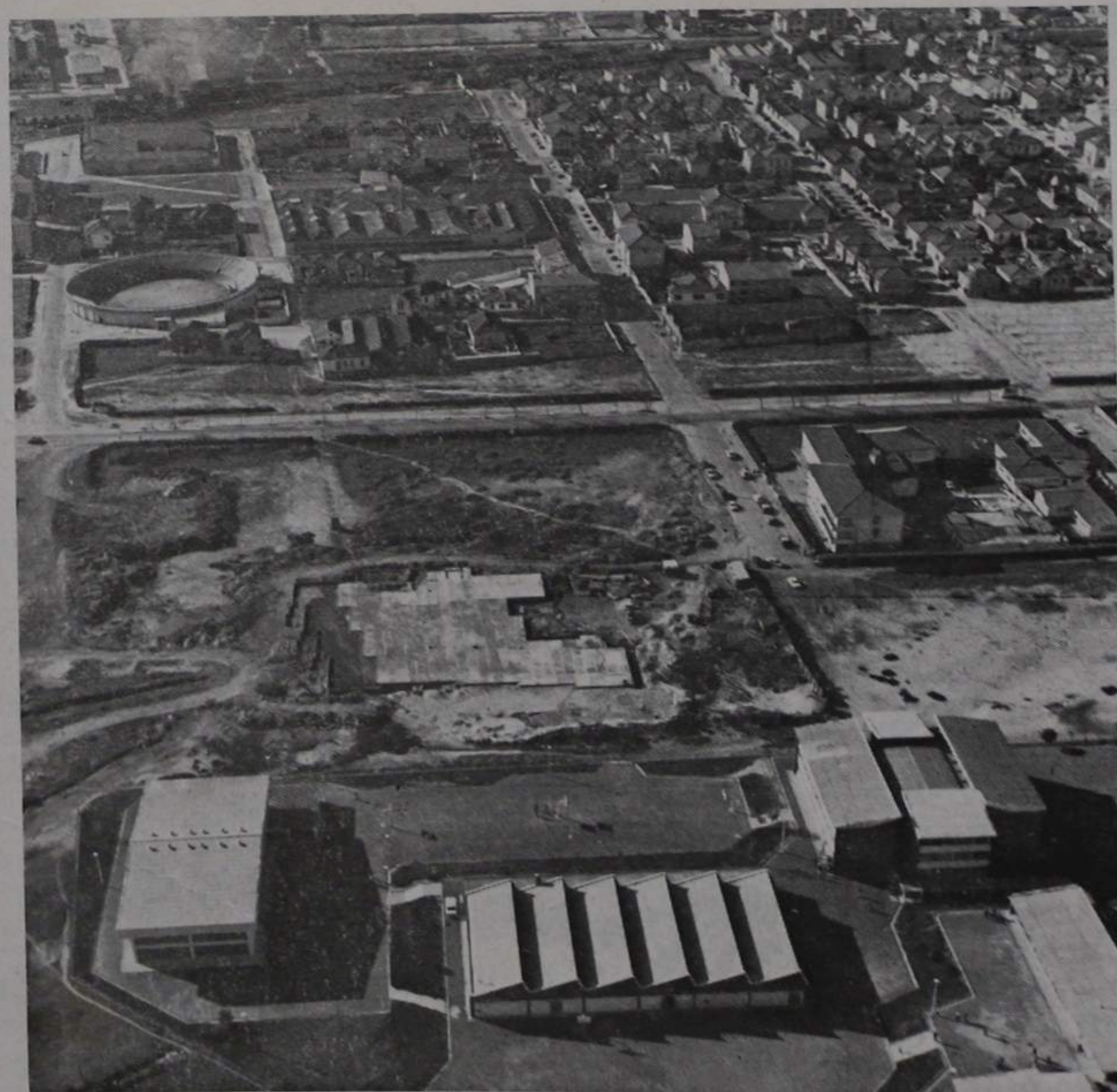
Vista aérea da zona da Cidade onde estão instalados a Escola Comercial e Industrial e o Hospital. No terreno contíguo à Escola, em primeiro plano, está a ser construído o Infância. As obras estão paradas nos alicerces, mas fazemos votos para que recomecem o mais breve possível.
