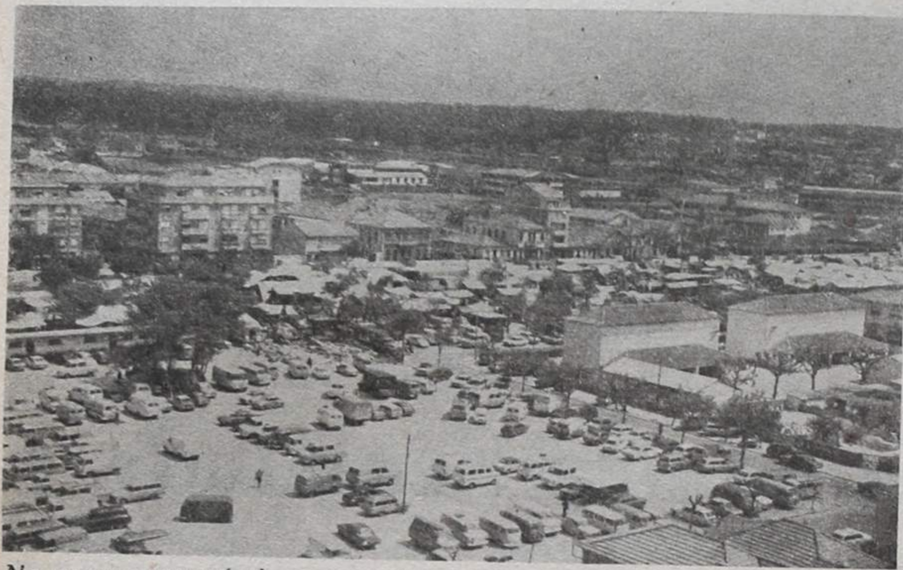
No parque automóvel em primeiro plano vai ser erguido um complexo que engloba Escolas Primárias com Cantina, Piscina coberta e Recintos Desportivos polivalentes.
