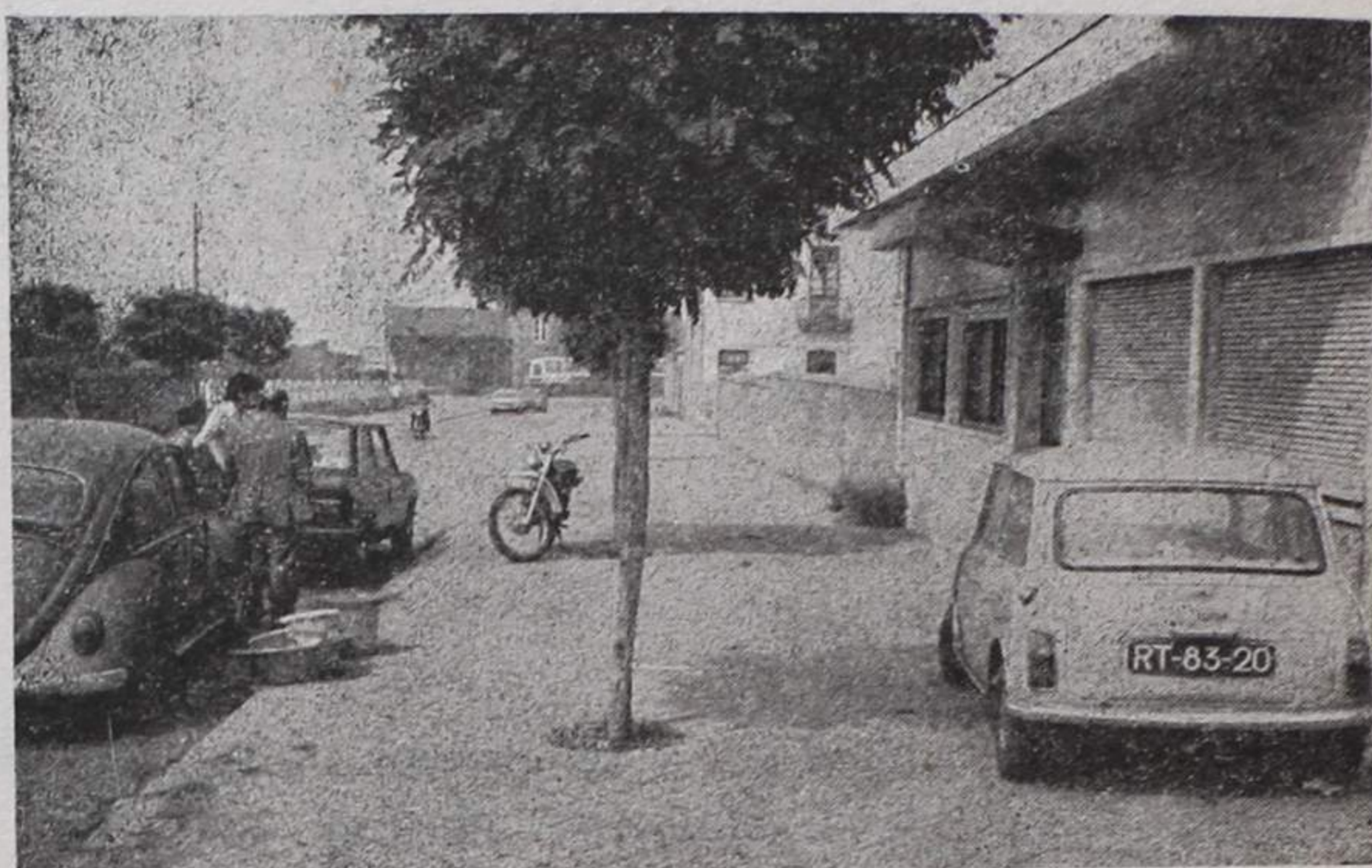
Não propomos passeios de tijoleira, como se pretende fazer na Rua 19, mas, no mínimo, regularizar o seu piso em balastro. E tratar de fazer uma melhoria de acordo com as possibilidades disponíveis...
