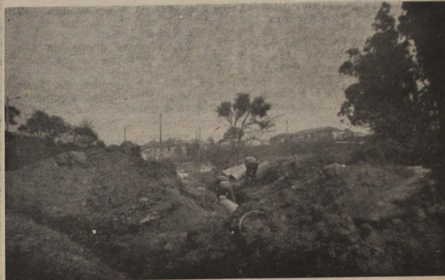
As obras do parque de campismo da Quinta do Tavares começaram em grande ritmo
