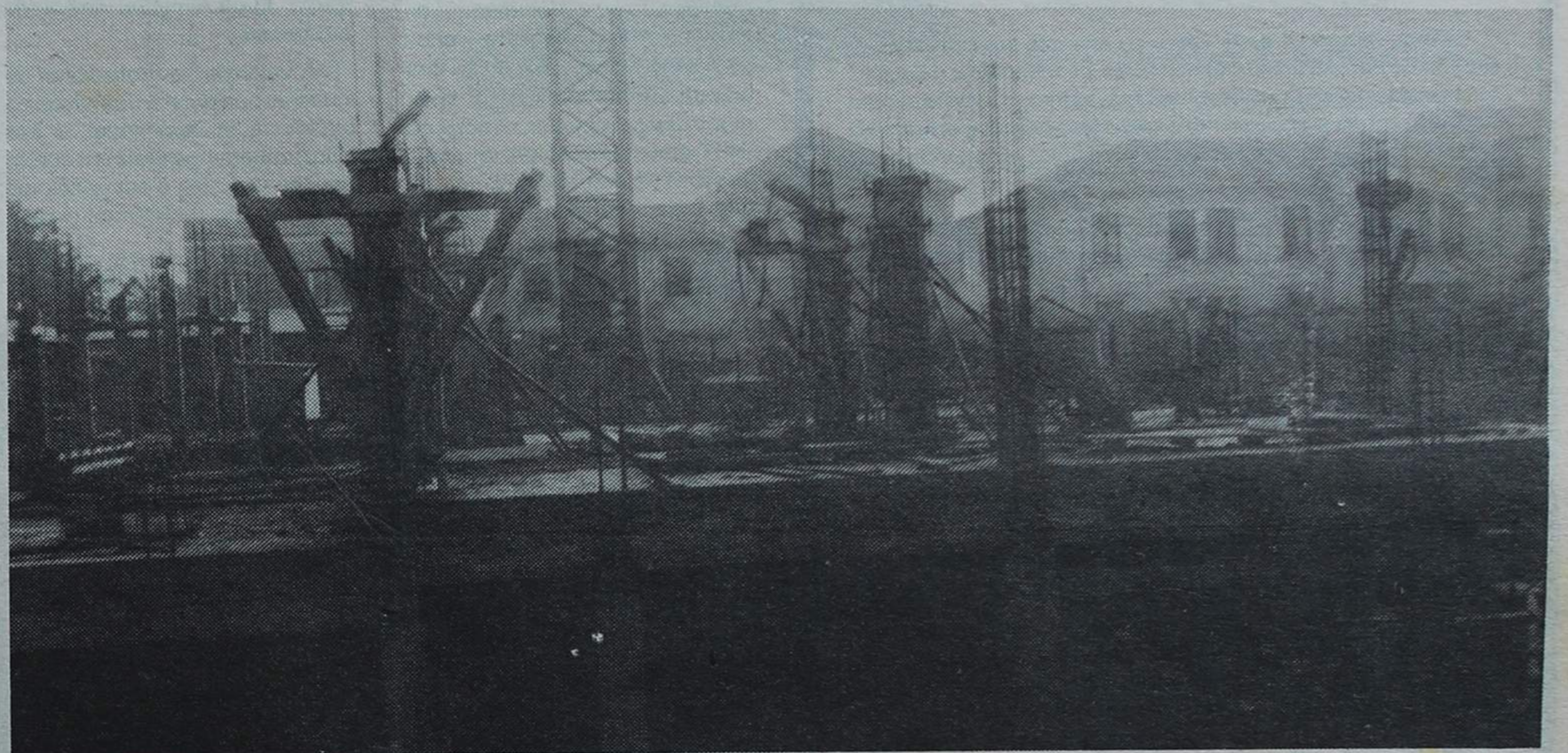
Um aspecto das obras
