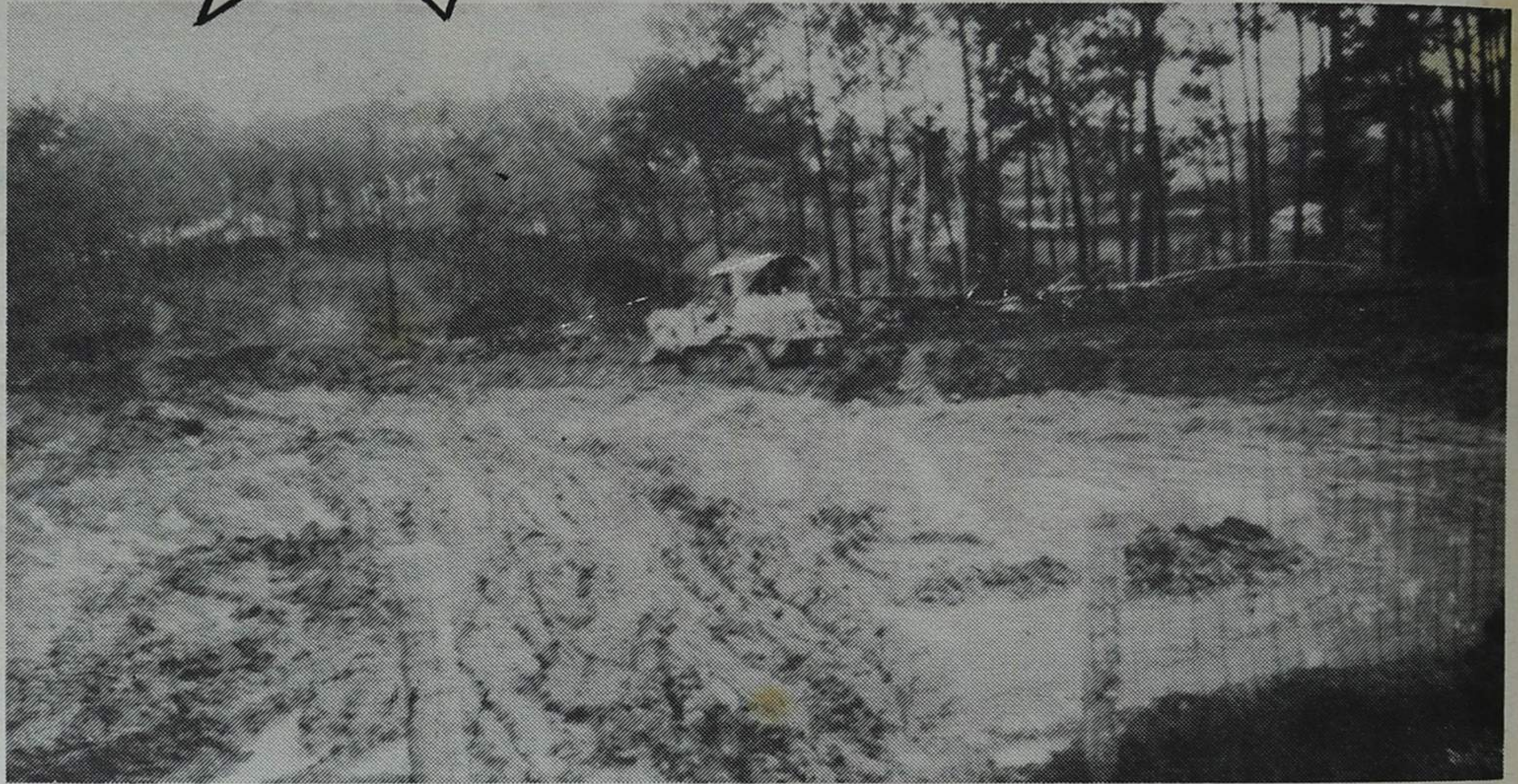
Um aspecto dos trabalhos de terraplenagem
