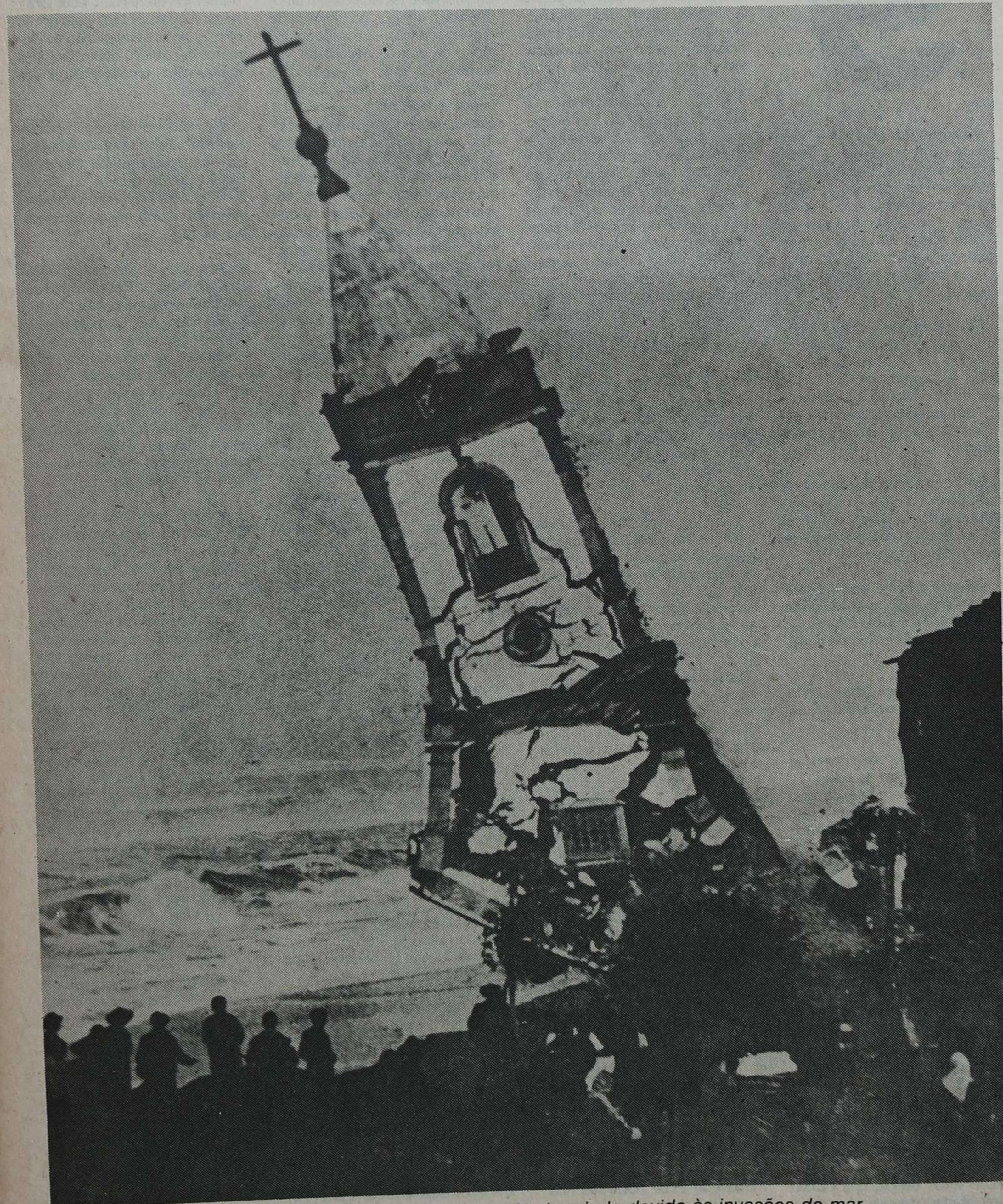
A primeira capela da Senhora da Ajuda ruindo devido às invasões do mar
