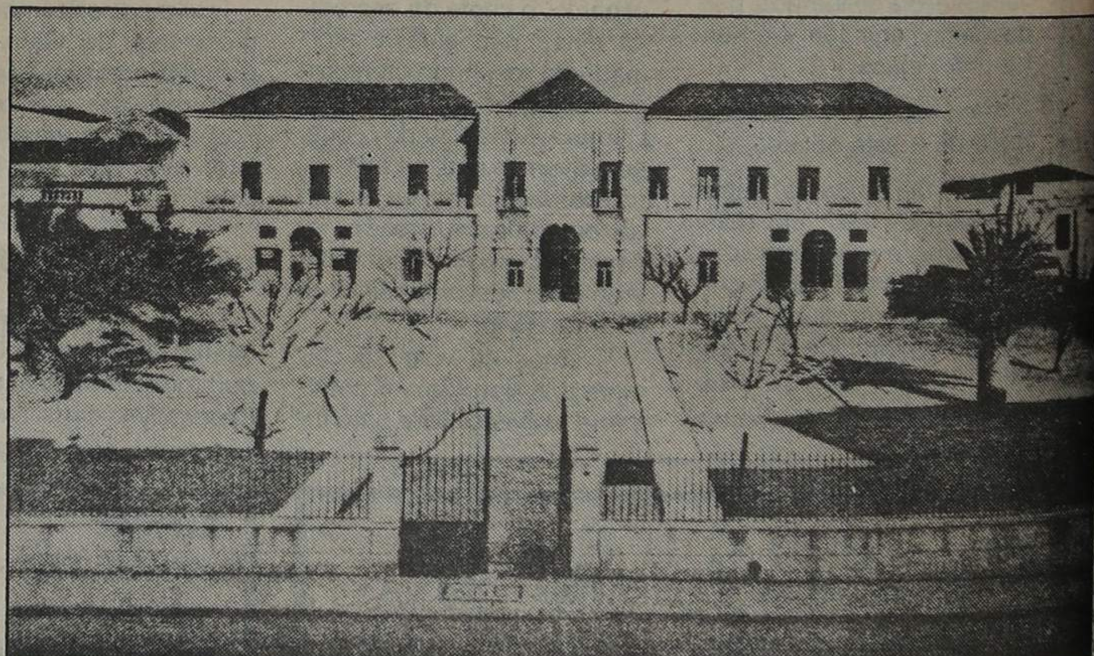
O frontespício do Palácio da Ega, onde funciona o Arquivo Histórico Ultramarino
