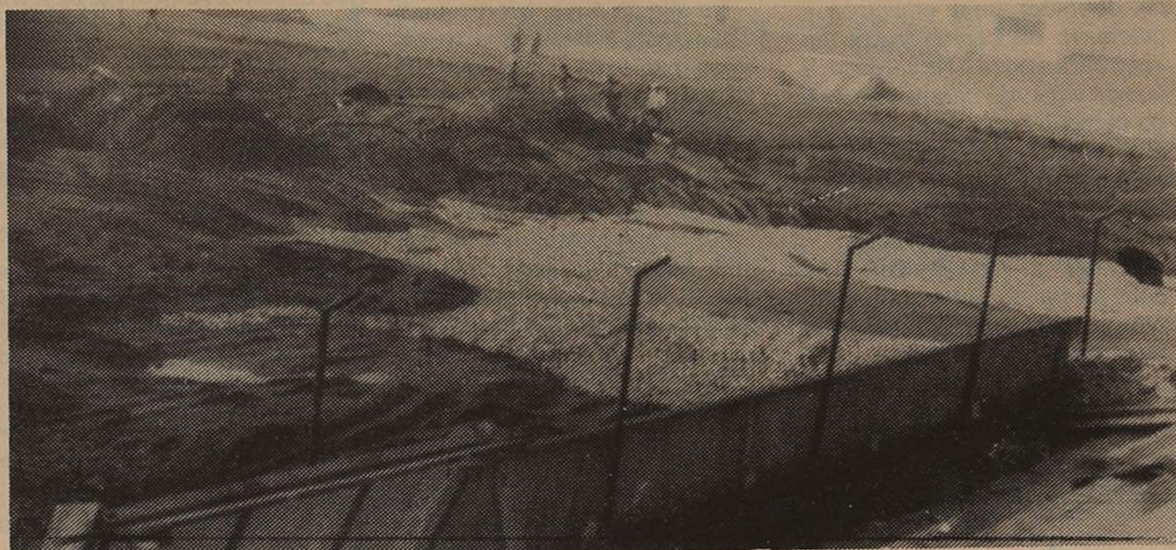
Os trabalhos de arrelvamento em curso
