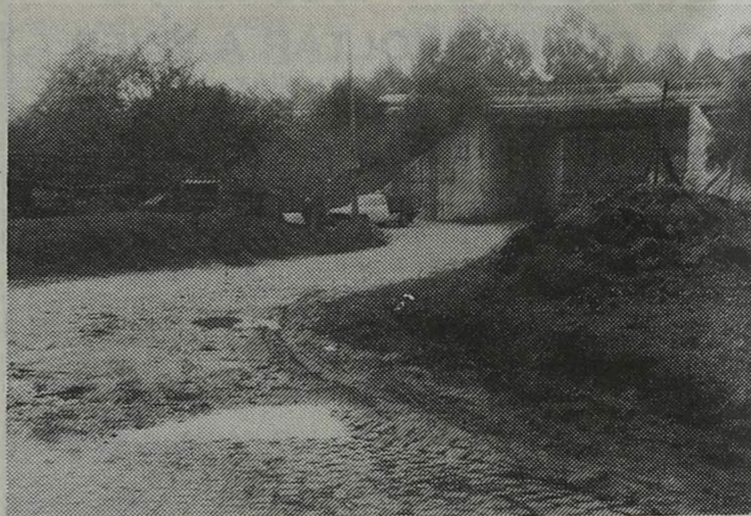
Foto 3 — Lá ao cima a auto-estrada: macia, uma maravilha. Por baixo, este lindo serviço — fotos António Pereira
