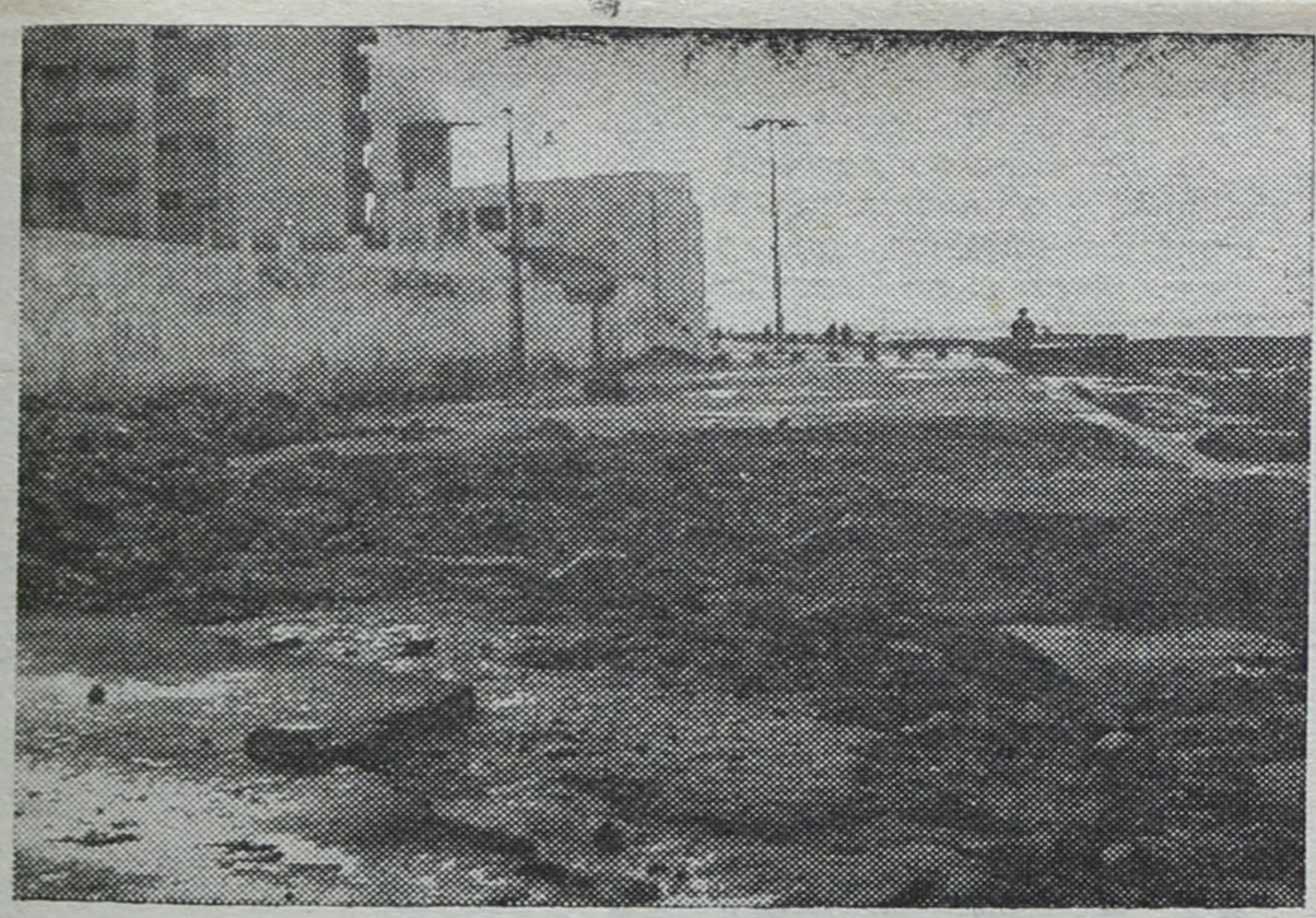
Para a zona da Piscina a defesa da costa ainda não começou. Mas vem aí a obra 4!
