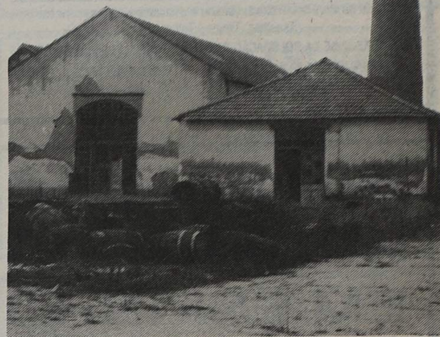
Fábrica Brandão Gomes, aspecto parcial: adquirida em 86 pela Câmara
