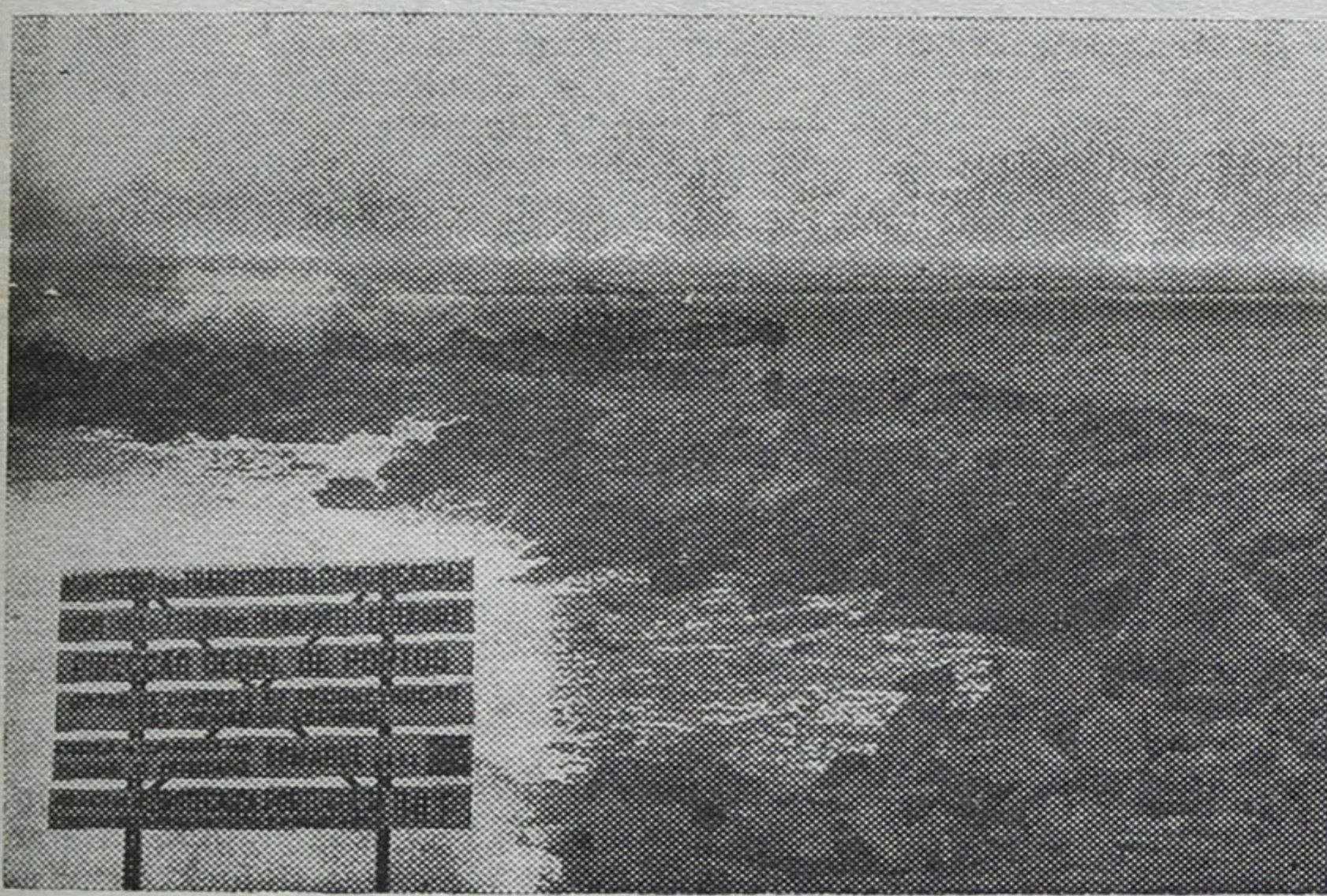
Conforme desenvolvemos alargadamente na passada semana, começaram em bom ritmo as obras do novo esporão frente à Piscina. Depois, será a confirmação da real importância da obra.
