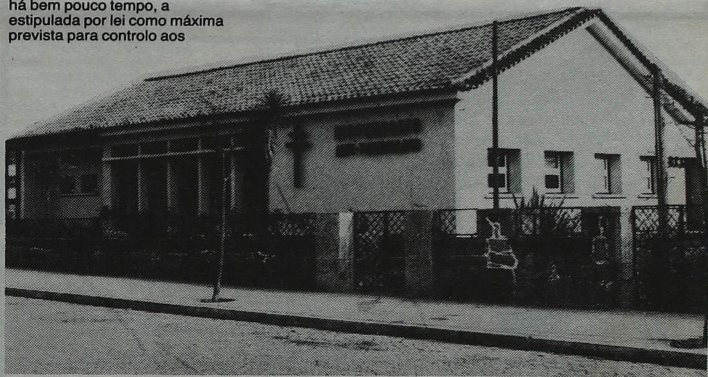
Neste edifício funciona, desde 7 de Janeiro de 1985, o Serviço de Alcoologia do Centro de Saúde de Espinho
