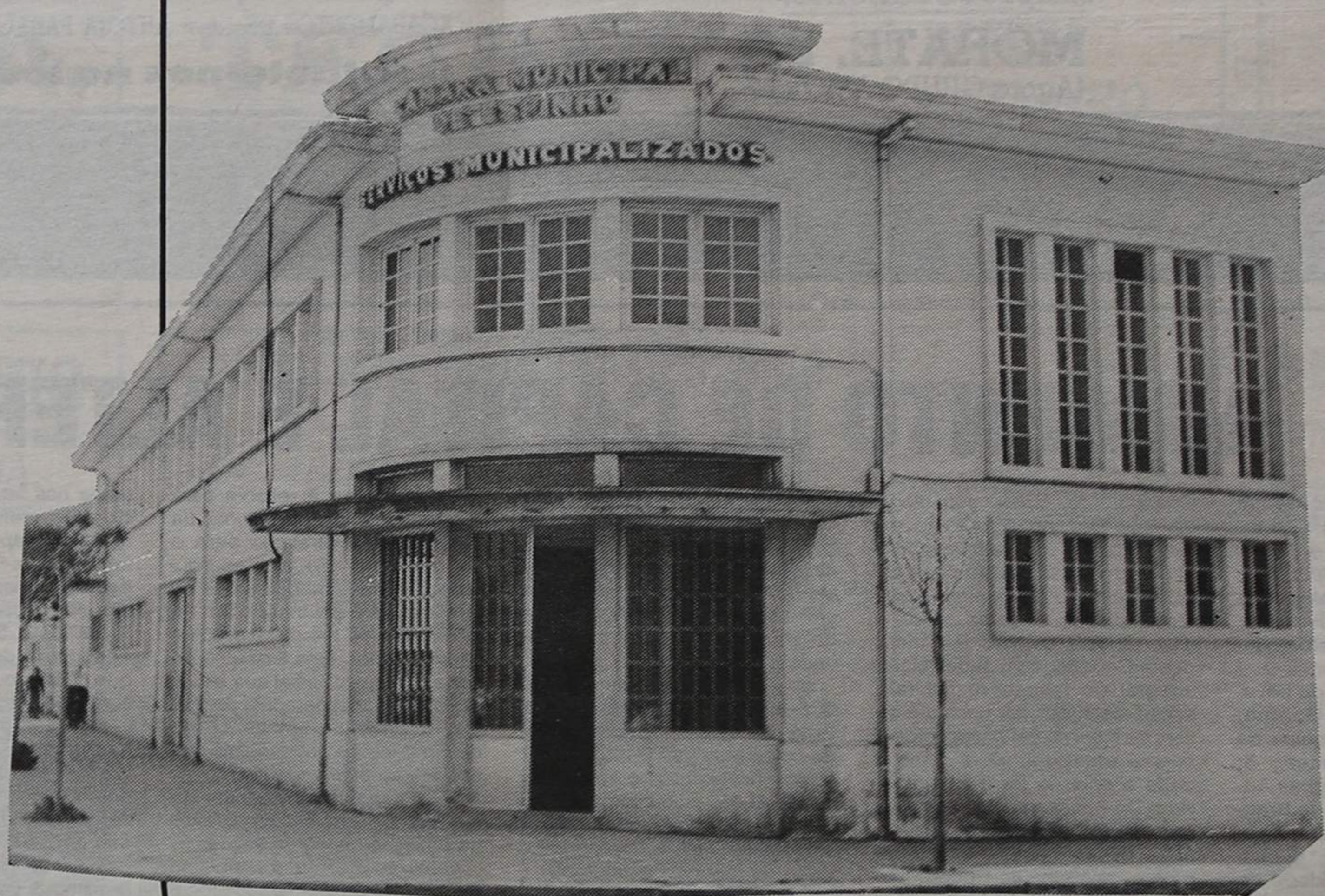
Imóvel dos Serviços Municipalizados de Espinho. De acordo com o protocolo Câmara/EDP, o edifício continuará pertença camarária e ali se manterá o departamento de águas
