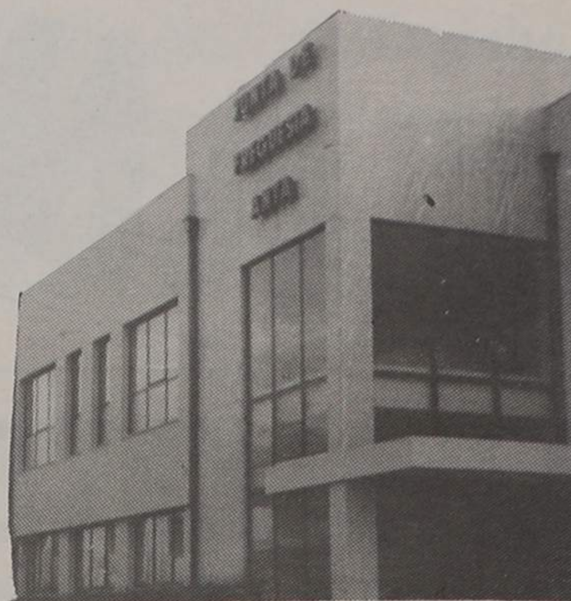
Aspecto do novo edifício da Junta
