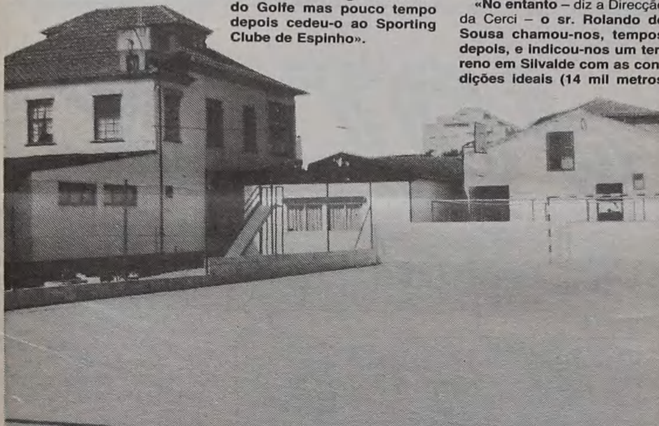
Cerciespinho — Actual casa sem condições, como se pode ver
